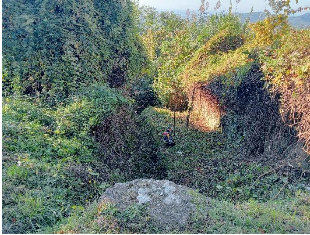
FOTO N° 5 Vallone "S. Ianni" - Cantiere Orria
