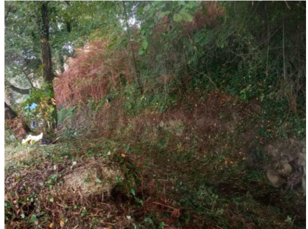
FOTO N° 6 Vallone "S. Crescenzo" - Cantiere Vallo della Lucania
