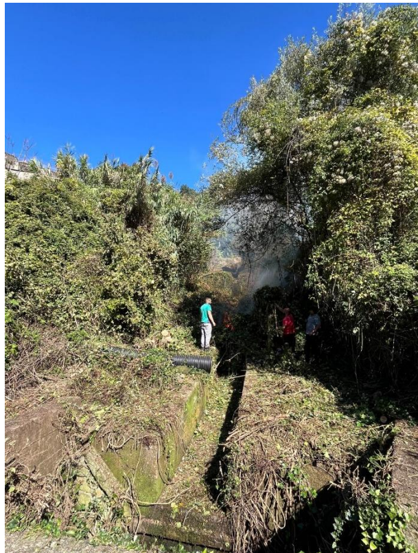
FOTO N° 4 Vallone "Cerreto" - Cantiere Orria
