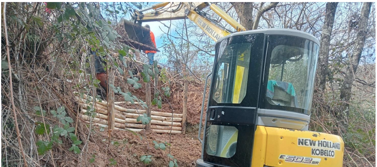
FOTO N° 22 Realizzazione palizzata in legno – Cantiere Orria
