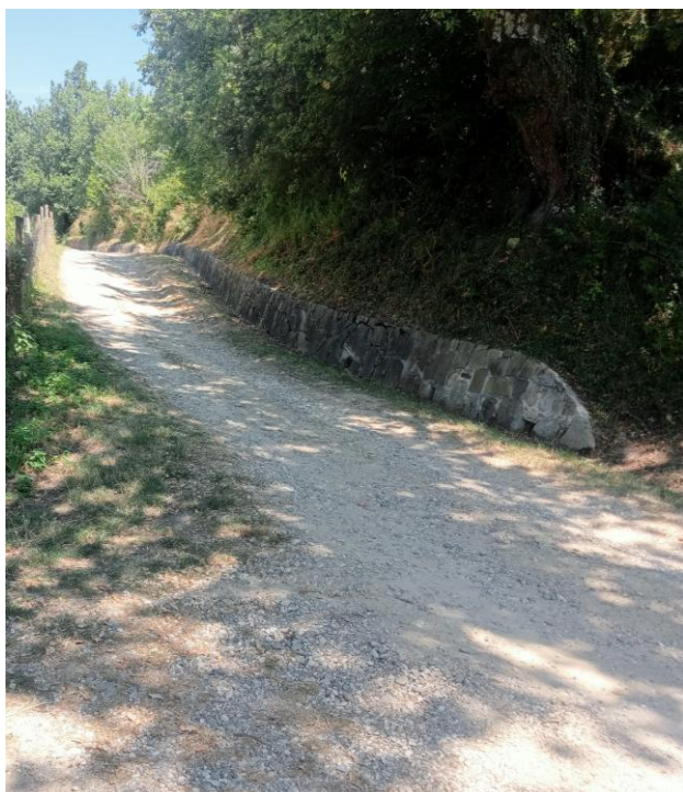
FOTO N° 7 Sistemazione viabilità rurale "costa delle Monache" – Cantiere Ceraso
