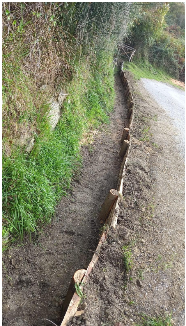
FOTO N° 23 Realizzazione palizzata in legno – Cantiere Ceraso
