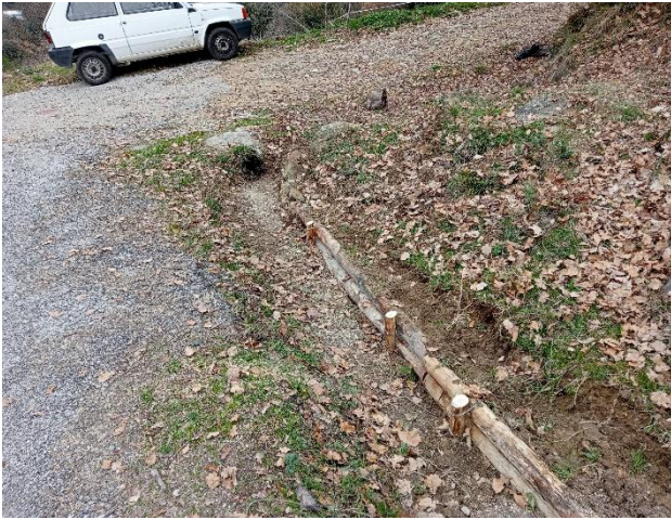
FOTO N° 18 Realizzazione Palizzata "loc. Rupicella" – Cantiere Gioi
