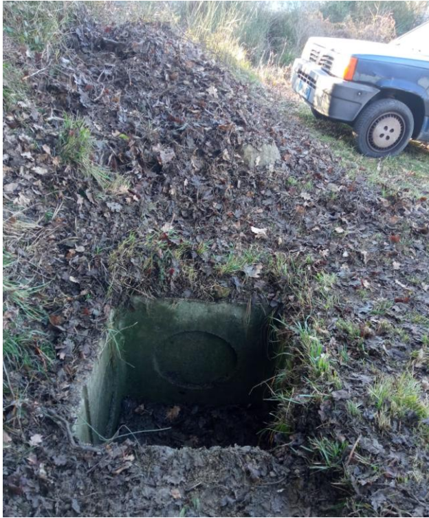
FOTO N° 12 Sistemazione viabilità rurale mediante la ripulitura di tratti intubati "loc. Treono" – Cantiere Gioi
