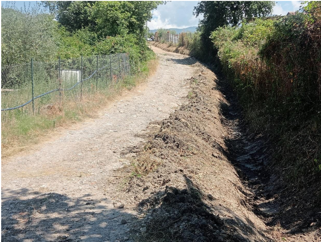
FOTO N° 10 Sistemazione viabilità rurale e ripulitura cunetta "loc. Tempa di Fusco" – Cantiere Ceraso
