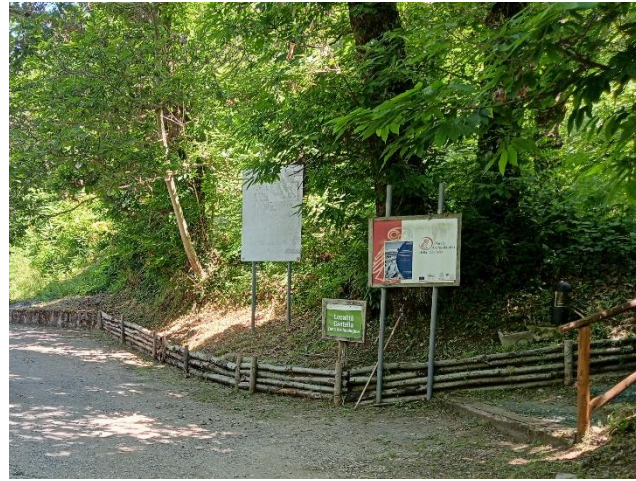
FOTO N° 21 Ripristino Palizzata esistente "loc. Civitella" – Cantiere Moio della Civitella
