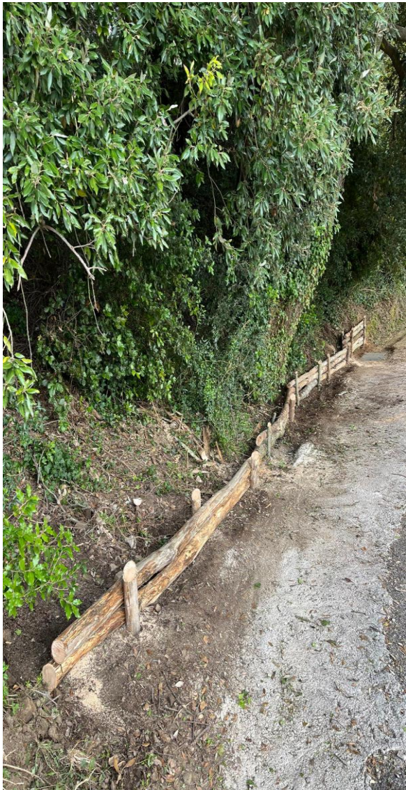
FOTO N° 22 Realizzazione palizzata in legno – Cantiere Orria
