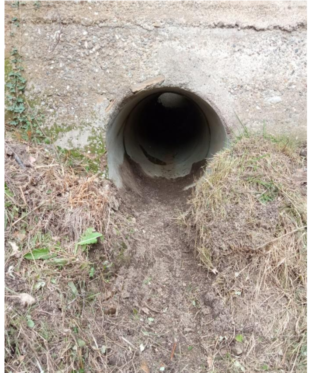
FOTO N° 13 Sistemazione viabilità rurale mediante la ripulitura di tratti intubati "loc. S. Ianni" – Cantiere Orria
