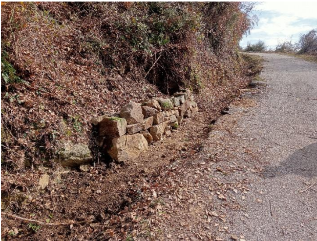
FOTO N° 20 Ripristino muri di contenimento in pietra "loc. Rupicella" – Cantiere Gioi
