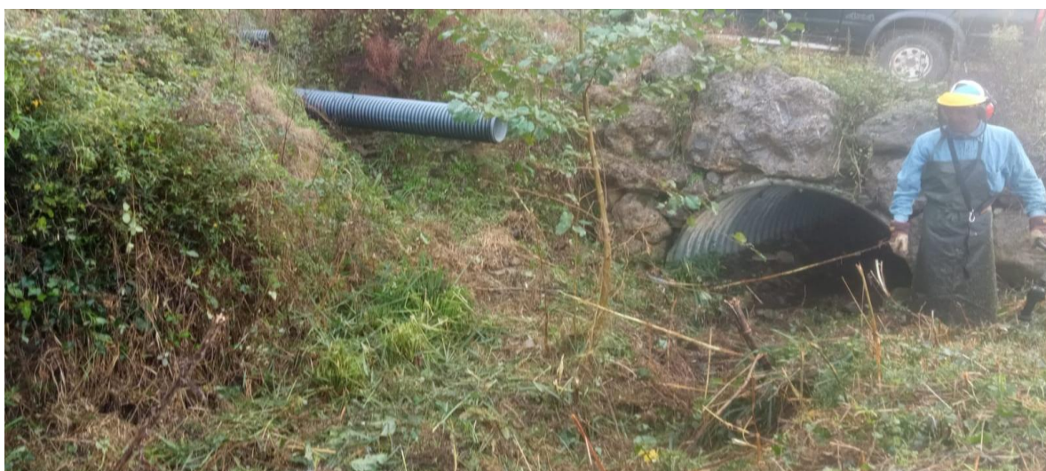
FOTO N° 17 Ripristino sistemi di drenaggio con tubi corrugati – Cantiere Orria
